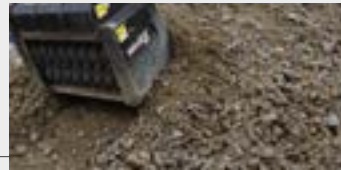
RECUPERACIÓN DE RESTOS DE DEMOLICIÓN
