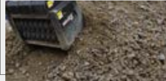
RÉCUPÉRATION DES GRAVATS DE DÉMOLITION
