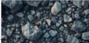
NETTOYAGE DU TERRAIN (DÉBRIS, PIERRES, GRAVIER)
